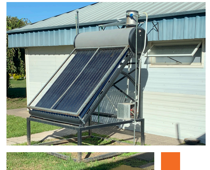
下の画像：グエメス製造拠点にある生活用水（シャワーと洗面台）の太陽熱温水器
